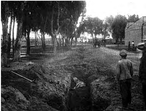
D.R. Instituto Nacional de Antropología e Historia, México. Casasola, Agustín Víctor. Introducción del drenaje en la calzada de la Ronda . 1927-09-27. Fototeca Nacional. https://mediateca.inah.gob.mx/repositorio/islandora/object/fotografia%3A144026
